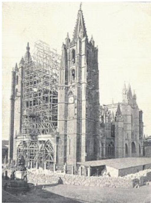
en pleno proceso de restauración
