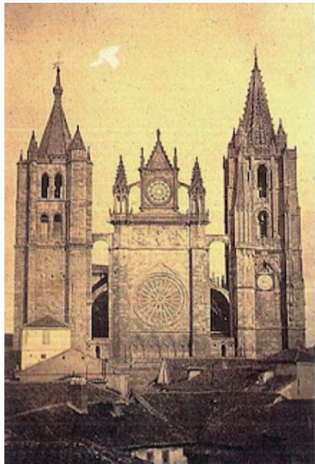
1875, antes de la restauración. Fachada occidental
