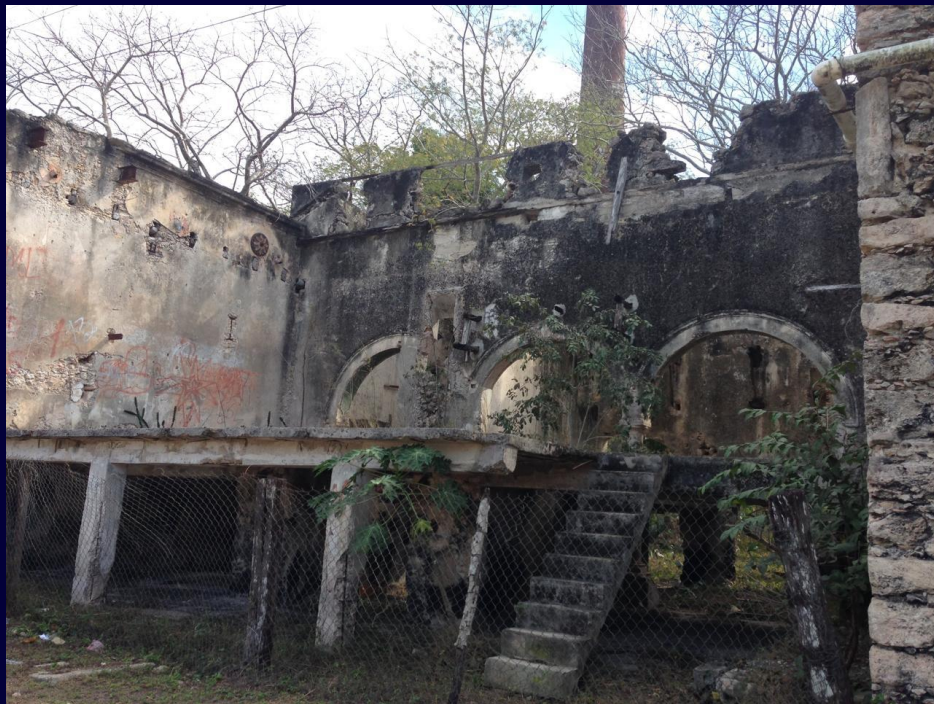
Casa de máquinas , Hacienda Ticopó, Yuc
